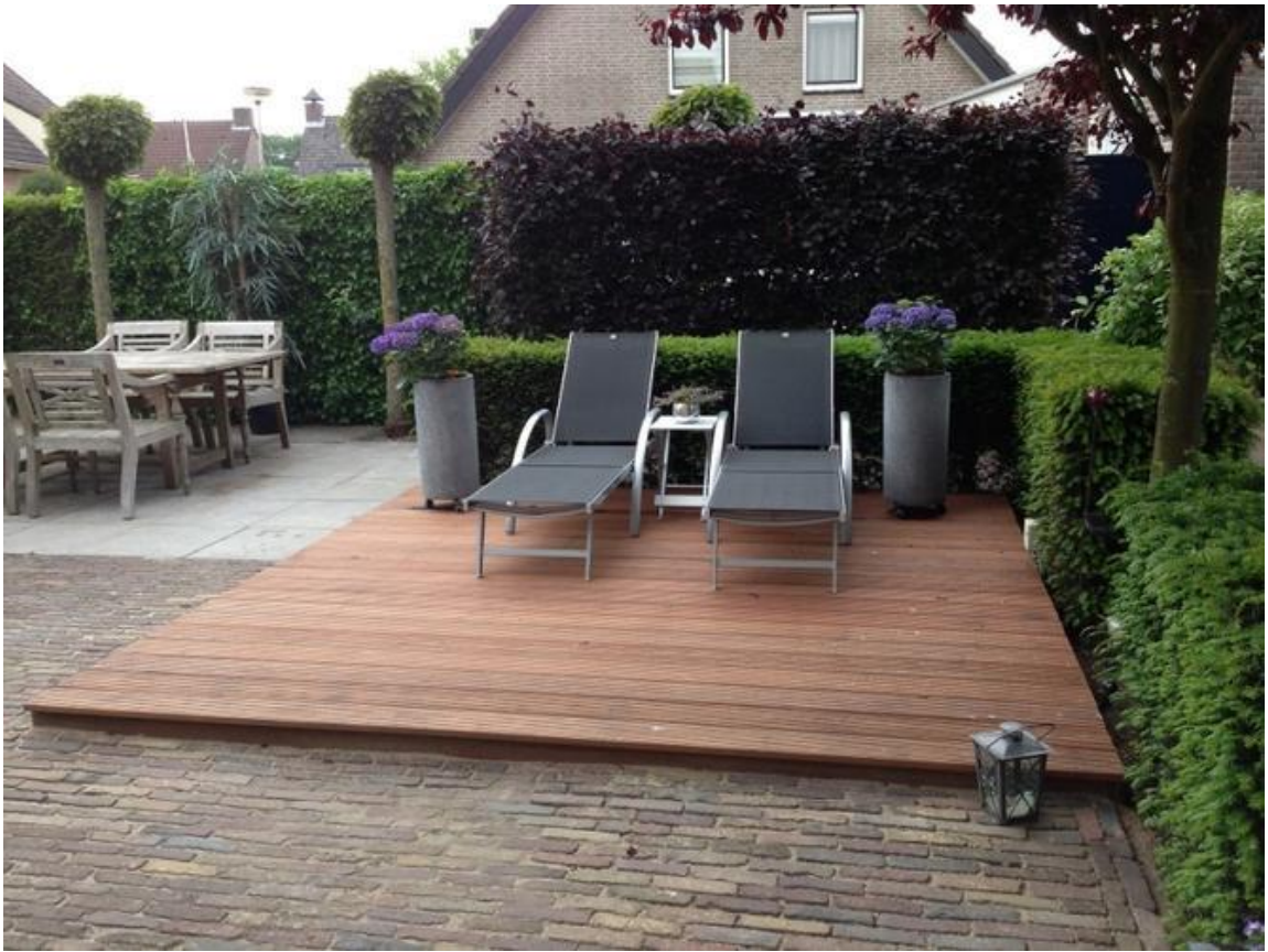
deze vlonder ligt op P+10 boven de bestrating
